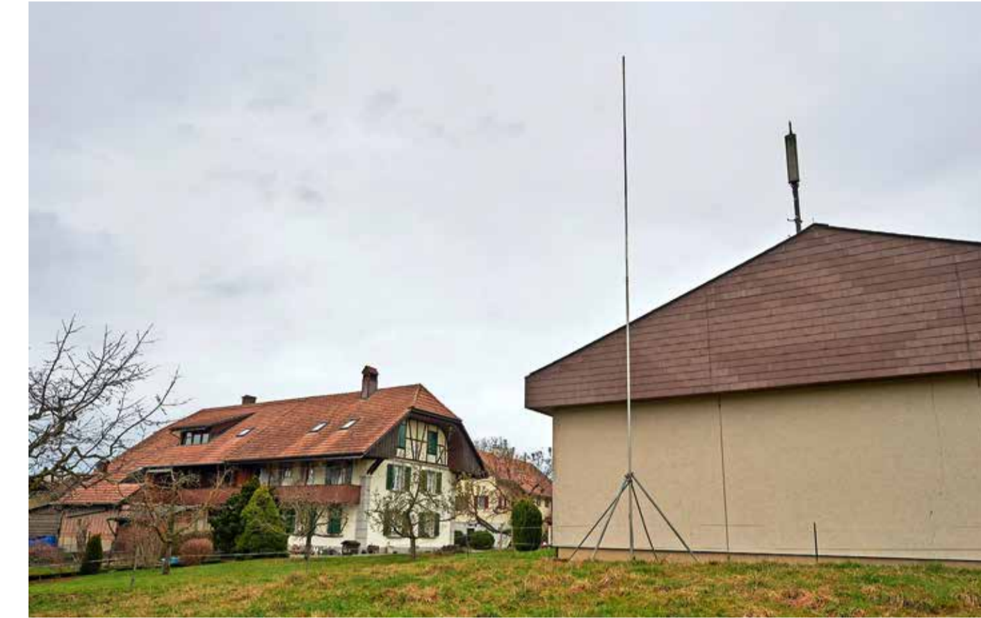
Noch steht das Profil, doch die Swisscom hat das Baugesuch für die neue Antenne in Jeuss zurückgezogen.
