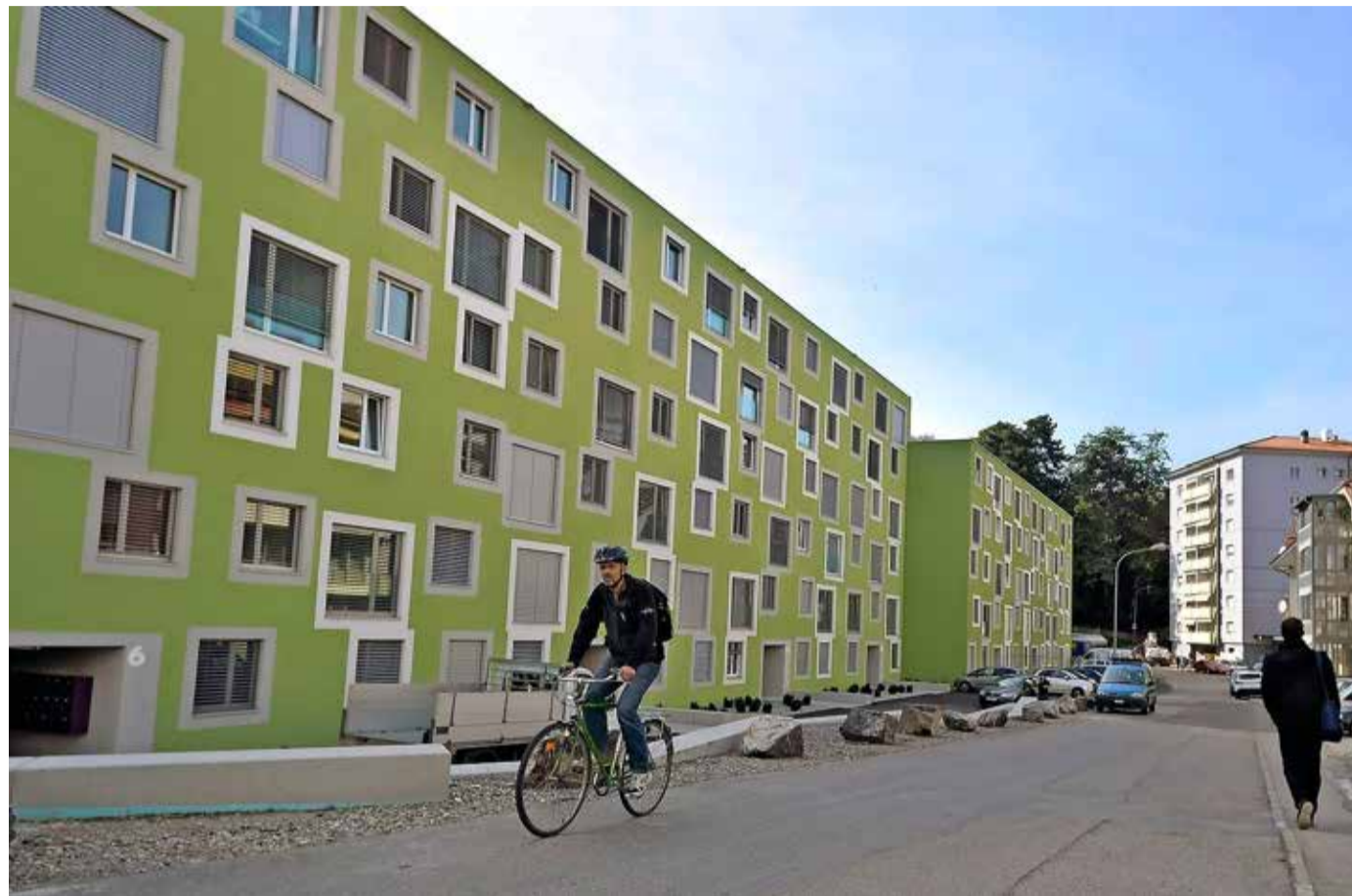
Die Überbauung am Freiburger Monséjour-Weg (Bild) ist ein Musterbeispiel für verdichtetes Bauen.
